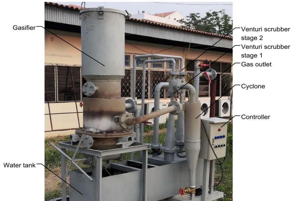
รูปที่ 5 การสร้างและการติดตั้งระบบแก๊สซิฟิเคชัน
